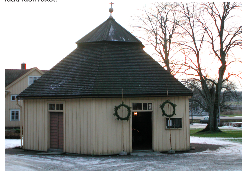
Brunns huset, exteriör
