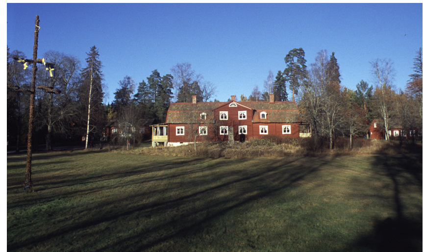
Området söder om nybygget
